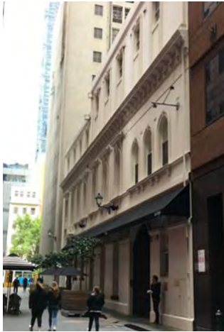
Figure 3. 7-9 Alfred Place, former Deutscher Verein von Victoria premises constructed 1885-6 (Source: Context, 2017)
