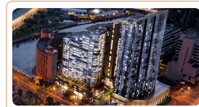
FLINDERS BANK/ ST REGIS HOTEL:
